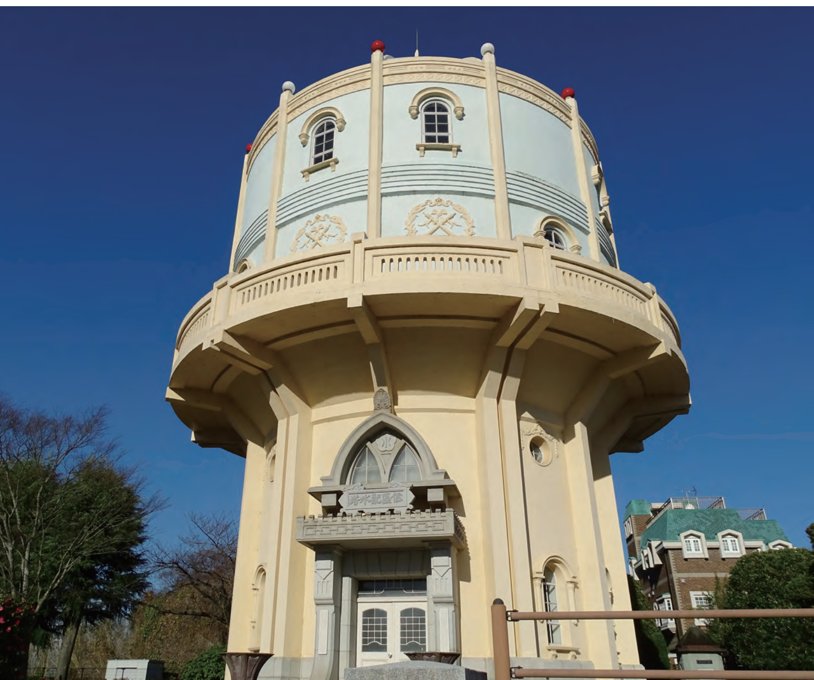
水戸市水道低区配水塔
